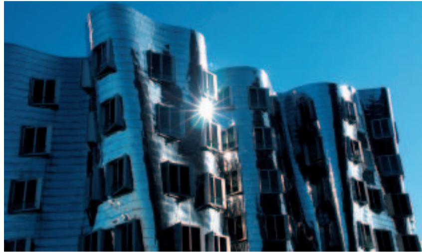
Nicht nur der Düsseldorfer Medienhafen soll glänzen: Die Stadt investiert kräftig in Schulsanierungen.
