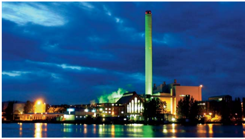
Das Kraftwerk der Stadtwerke Flensburg speist eines der größten Fernwärmenetze in Deutschland.
