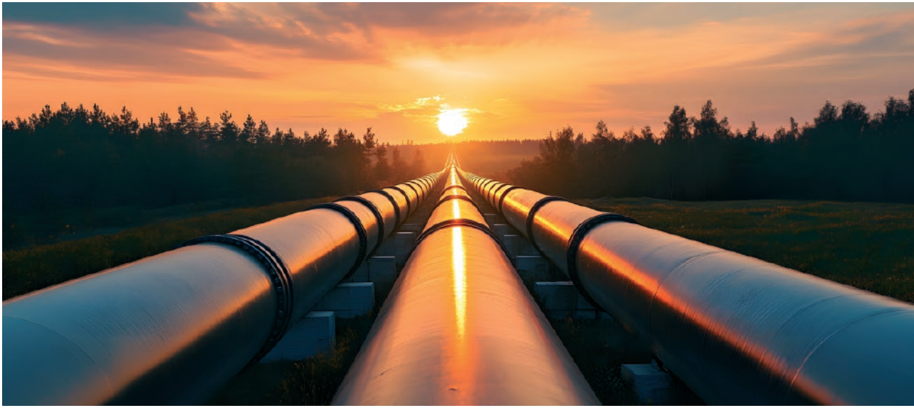
Was kommt nach dem Ende der konventionellen Gasversorgung? Das ist nur eine Frage, die sich Kommunen bei der Transformation stellen müssen.
